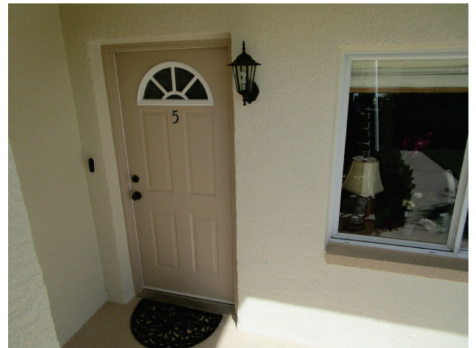
metal clad non impact entrances
